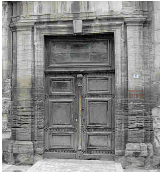
Altération de la pierre par les cristallisations salines de part et d'autre de la porte (alvéolisation) Carpentras, chapelle des pénitents noirs (photo P. Bromblet).
